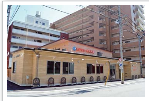
外観：木造 2 階建ての建物
