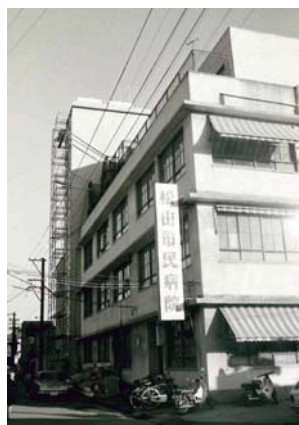
昭和 36 年完成の B 病棟 奥は 5 階建てに増築工事中
